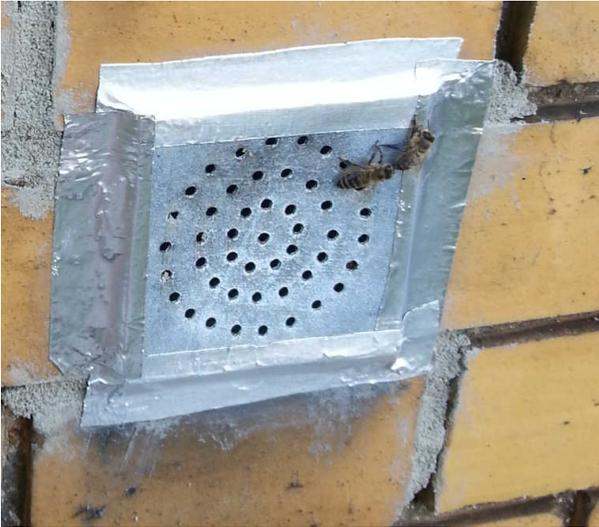
Abbildung 14: Verschließen der Öffnung an der Gebäudewand mit einer Verschlusskappe und Alu-Klebeband.
