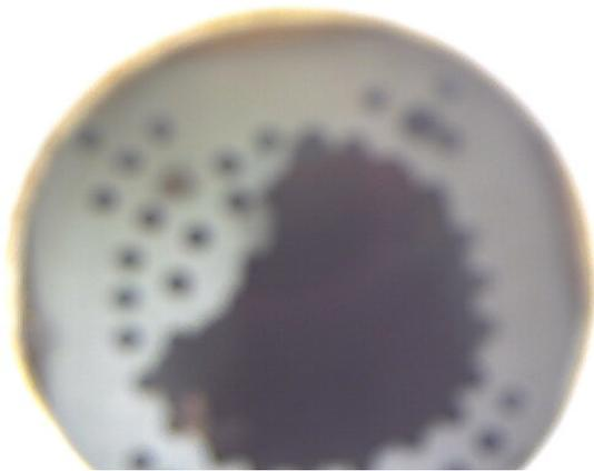
Abbildung 11: Flugloch von außen mit der Webcam aufgenommen. Sichtbar ist hier die verwitterte Verschlusskappe an der Gebäudewand. Die kreisrunde weiße Begrenzung des Bildausschnitts zeigt den weißen Kunststoffflansch, der an der Gebäudewand außen befestigt wurde.
