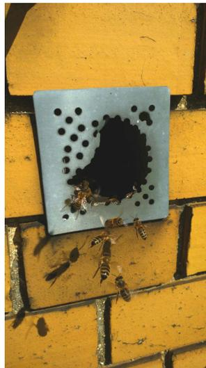
Abbildung 3: Beschädigte Verschlusskappe der Gebäudewand
