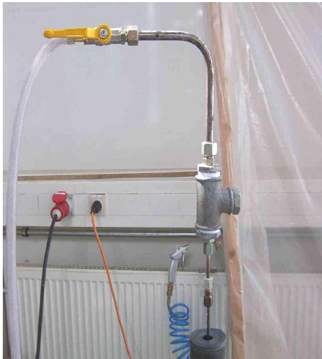
Natriumabscheider am Befüllrohr während des Evakuierens
