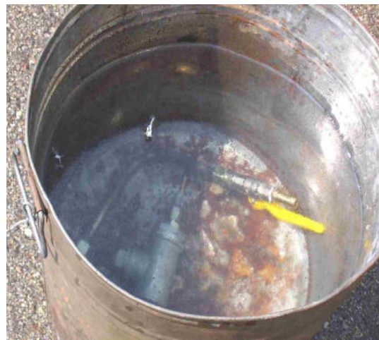
Reinigung von Rohren und Natriumabscheider. Dabei ist Vorsicht geboten. Abb. 6.1-2
